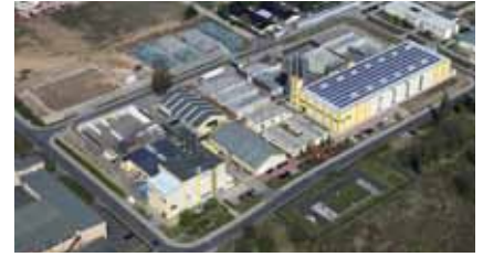
Polyester Aufbereitungswerk in Deutschland
